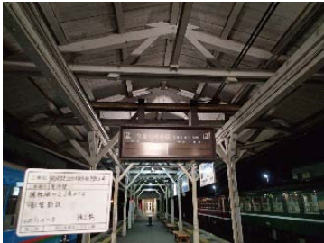
宮津駅2・3番のり場老朽発車標の取替
