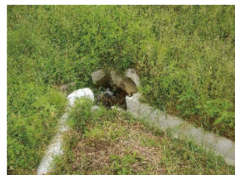
改良後の側溝
