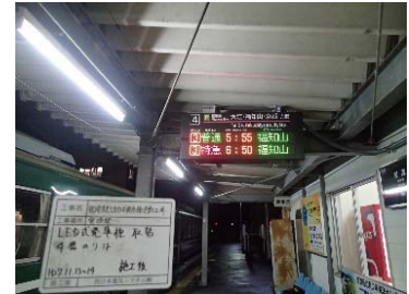
宮津駅4番のり場発車標新設
