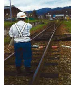
保守用車進路確認
