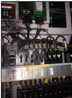
配電盤内損傷箇所
